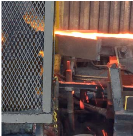
安装在热轧带钢生产线辊道平面下方
